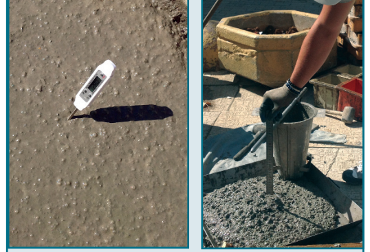
Beton harcın ısı ve kıvamı ölçülüyor
