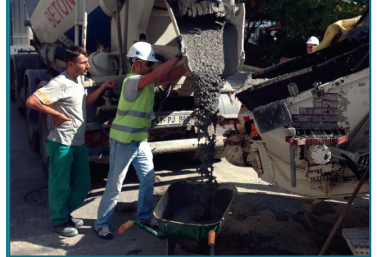
Mikserden beton alınıyor
