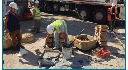
Beton numunesinin alınacağı yer inşaat teknikeri tarafından hazırlanıyor.
