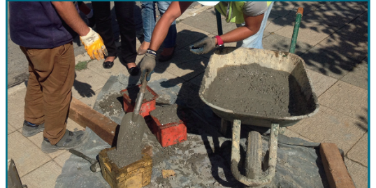
Harç donmak üzere özel kutulara dökülüyor ve etiketleniyor.
