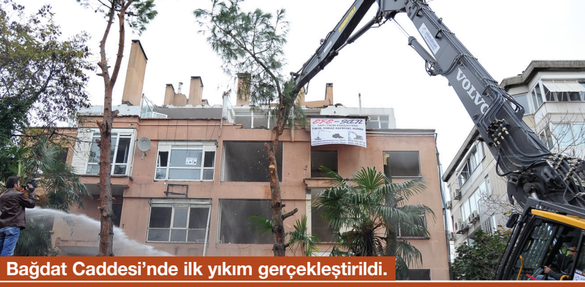
Bağdat Caddesi'nde ilk yıkım gerçekleştirildi.
